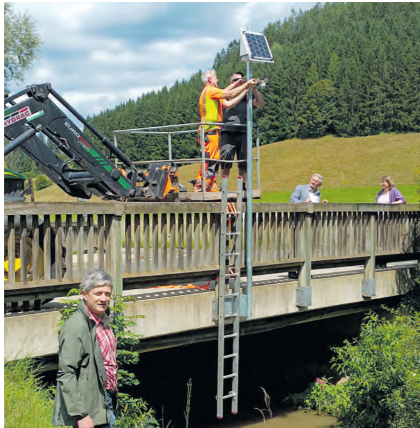
Montage Pegelmessstation Brücke Blumental
