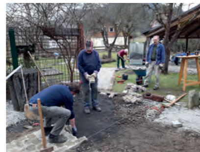
Die Wege im Garten Flora K wurden mit Steinplatten neu ausgelegt
